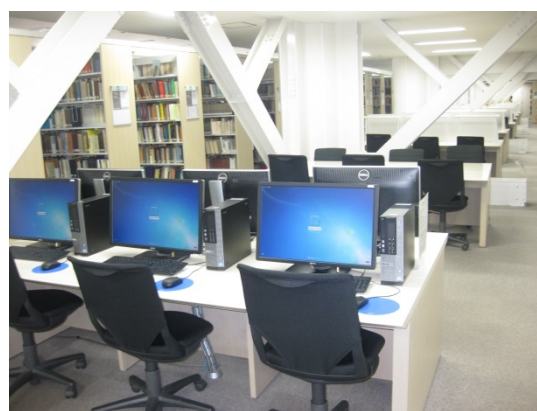
写真2 館内の耐震補強
