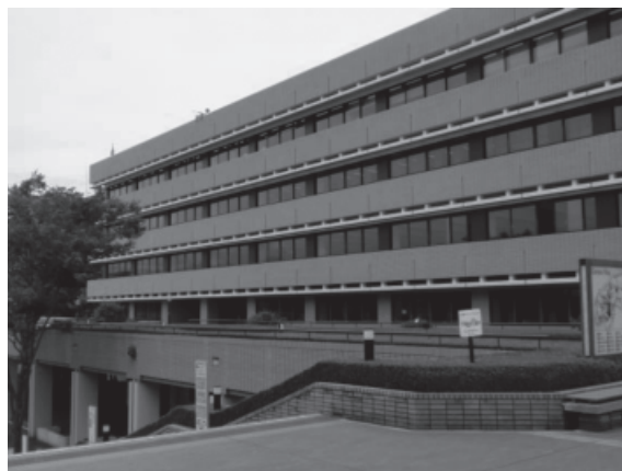
【写真1】多摩図書館の外観
