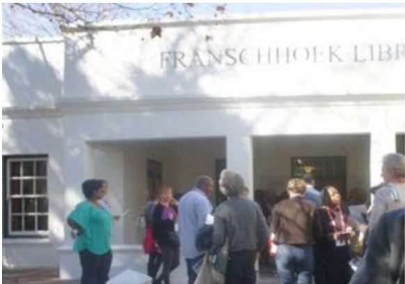
写真-8 フランシュフック公共図書館の入口
