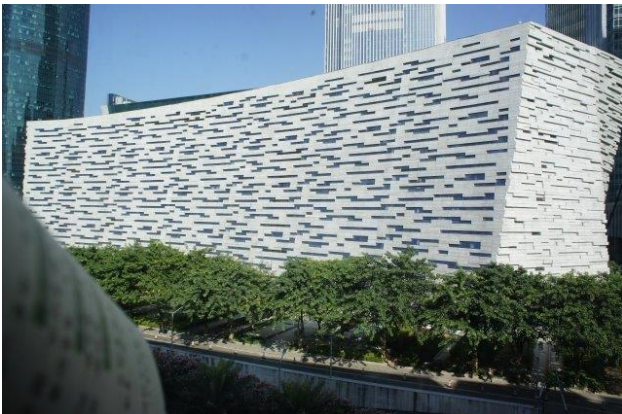
写真-15 広東省広州市広州図書館
