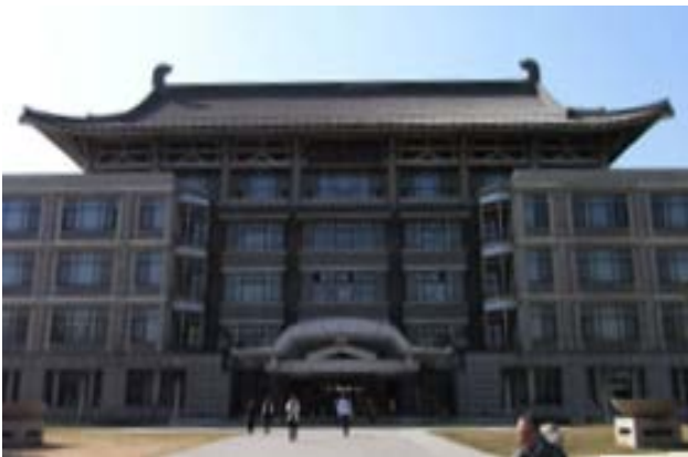
東楼の正面玄関
