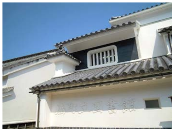
写真1 旧脇町図書館（図書館撮影）
